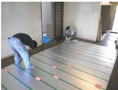
床暖房設置工事
