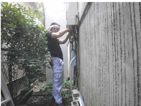
給湯器取替工事
